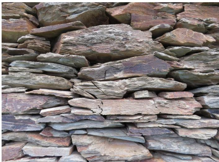
Figs. 14 a 16 - Sinais de deterioração (pontos de pressão) em muro de pedra. (Autor: Cristina Carlos /ADVID)
