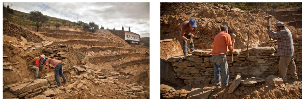
Figs. 42 e 43 - Construção de um muro de suporte em pedra posta na Quinta dos Malvedos. (Autor: Symington Family Estates)
