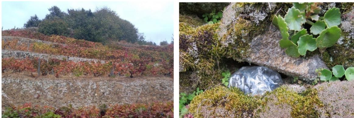
Figs. 50 e 51 - Exemplos de más práticas na manutenção de muros de pedra: à esquerda) muros revestidos com cimento; à direita) lixo colocado num orifício de um muro. (Autor: Cristina Carlos/ADVID)
