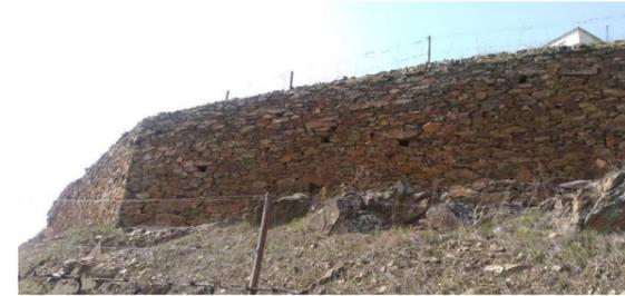
A água pode ficar retida por detrás de um muro e provocar a sua derrocada. O melhor será providenciar orifícios ou "boeiros" na base do muro, e juntar cerca de meio metro de cascalho entre o muro e o banco de terra.
