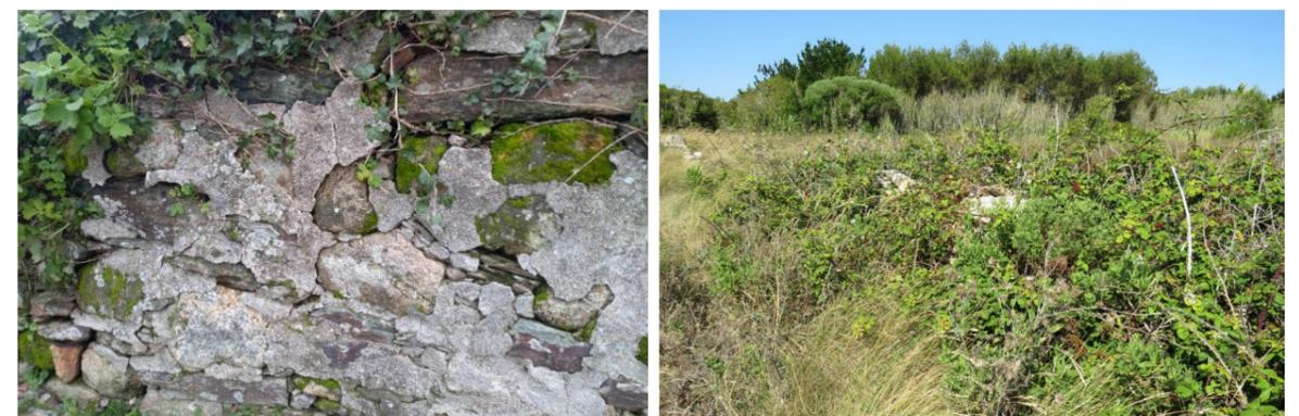
Fig. 57 e 58 - Exemplos de más práticas na manutenção de muros de pedra, na esquerda, muro rebocado com cimento (Autor: Cristina Carlos/ADVID), na direita, muro abandonado e ocupado por silvas. (Autor: Claudia Gonçalves / CAP)
