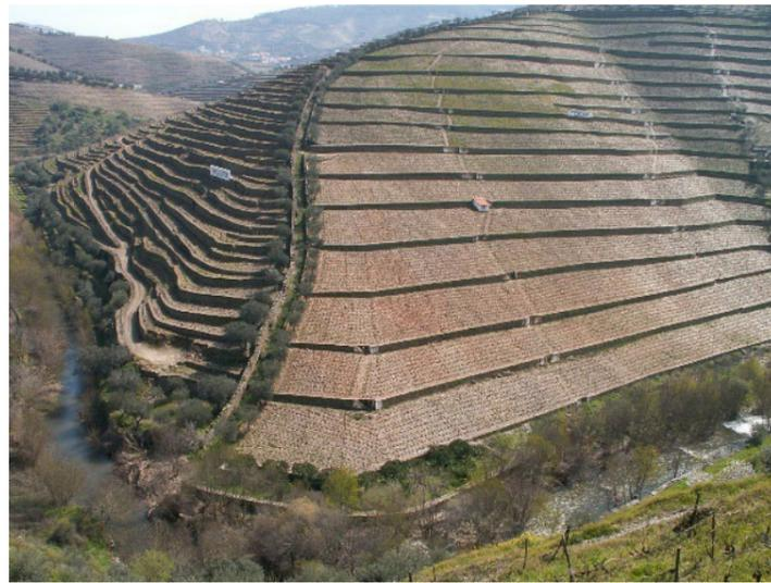
Fig. 26- Foto ilustrativa de dois tipos de muro de suporte, pré-filoxérico (no lado esquerdo) e pós-filoxérico (no lado direito). Quinta da Côrte (Valença do Douro). (Autor: Cristina Carlos /ADVID)
