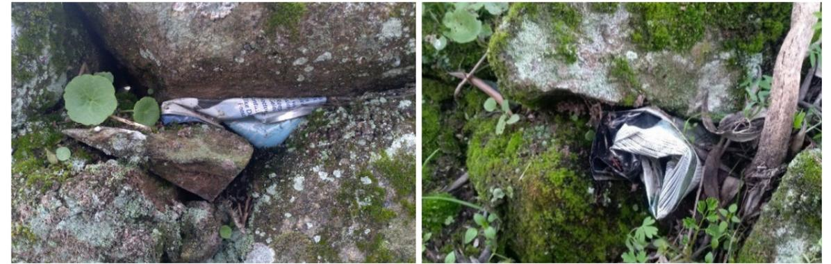
Fig. 52 e 53 - Exemplos de más práticas na manutenção de muros de pedra, neste caso, lixo (pacotes de fitofármacos e latas) deixado nos orifícios de muros de pedra. (Autor: Cristina Carlos/ADVID)
