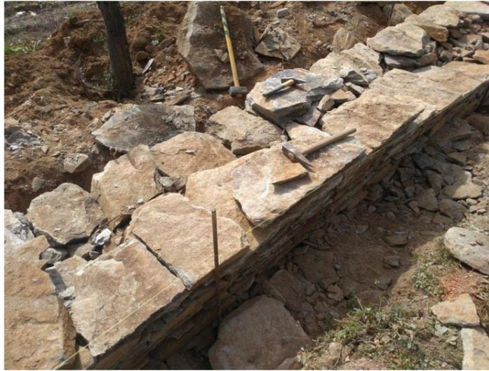
Fig. 33 - Ferramentas mais usadas pelo pedreiro na construção de muros de pedra. (Autor: Cristina Carlos/ADVID)
